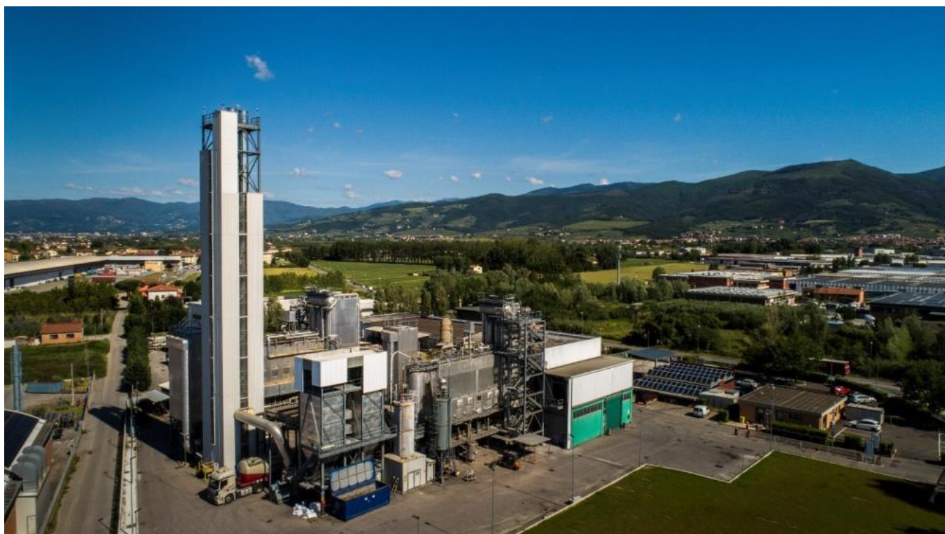
Figura 1 – Impianto di termovalorizzazione di Montale
